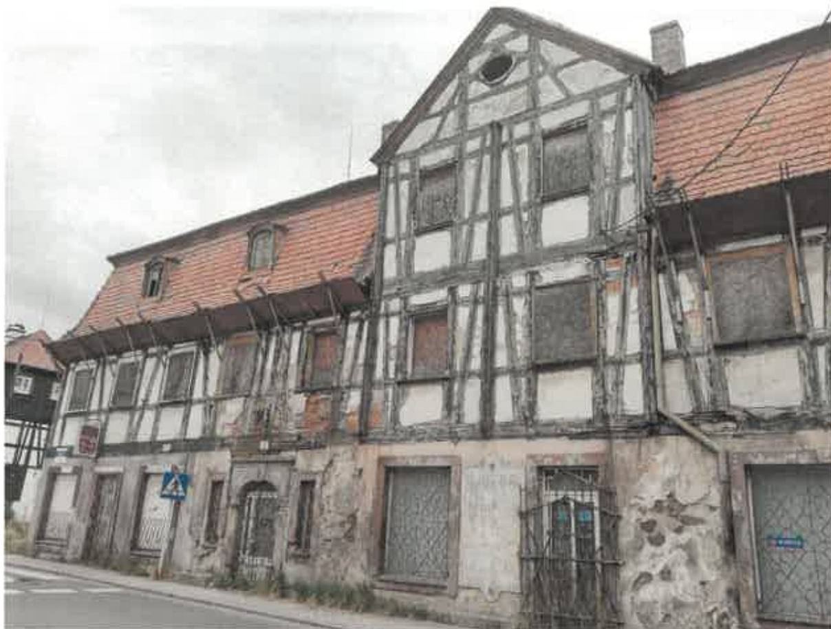
c) dom przystupowy przy ul. 1 Maja 3, podobszar rewitalizacji Bogatynia III
