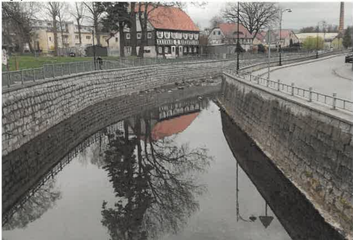
Rycina 15 Skanalizowana i zanieczyszczona rzeka Miedzianka przepływająca przez podobszar rewitalizacji Bogatynia III
